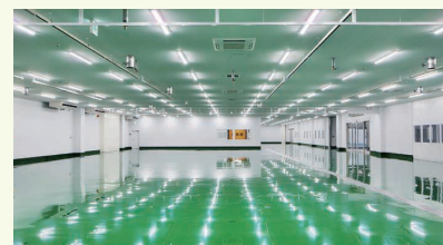
「ファブリカ流しのベSCR工法」施工イメージ
